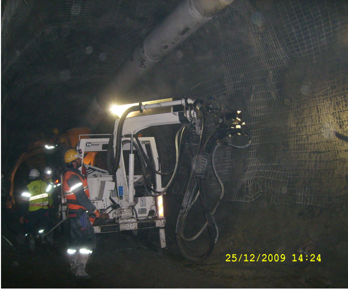
Resim 1. Fazla açılmaların püskürtme beton ile doldurulması
