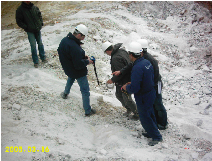
Şekil 12. Patlatma deliklerine yerleştirilen elektronik kapsüllerin gecikme sürelerinin yüzeyden ayarlanması
