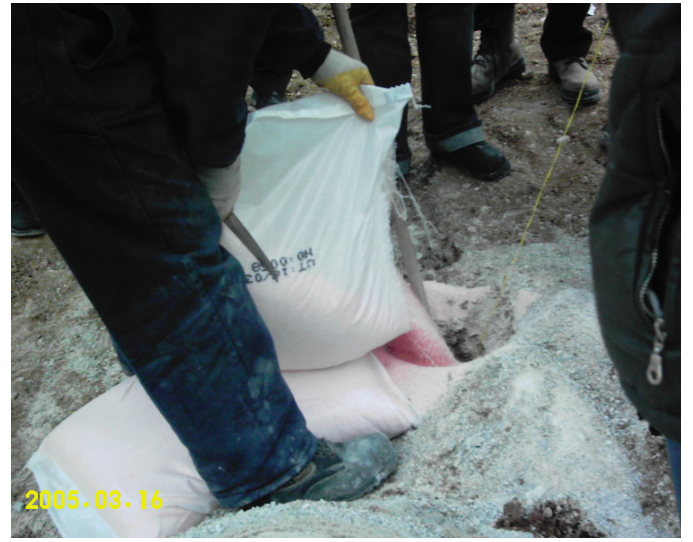
Şekil 13. Deliklerin ANFO ile doldurulması
